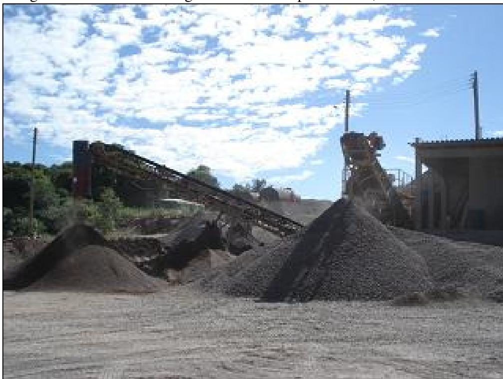
Figura 4. Unidade de britagem de coleta do pó de rocha, Nova Prata – RS.
